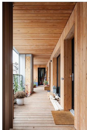
© Projet Brutopia à Forest, Stekke + Fraas Architectes et AAAA Architectes. Photo: Tim Van de Velde.
