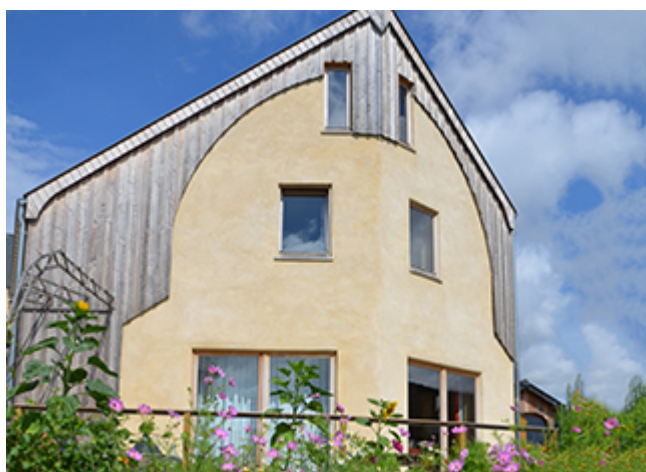
Une utilisation de la chaux : en façade
