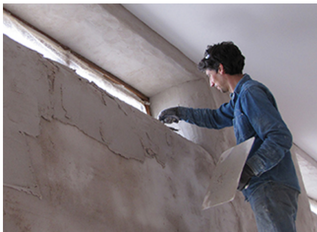
Plafonner avec de la chaux
