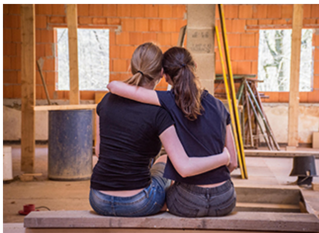
8 erreurs à éviter quand on rénove
