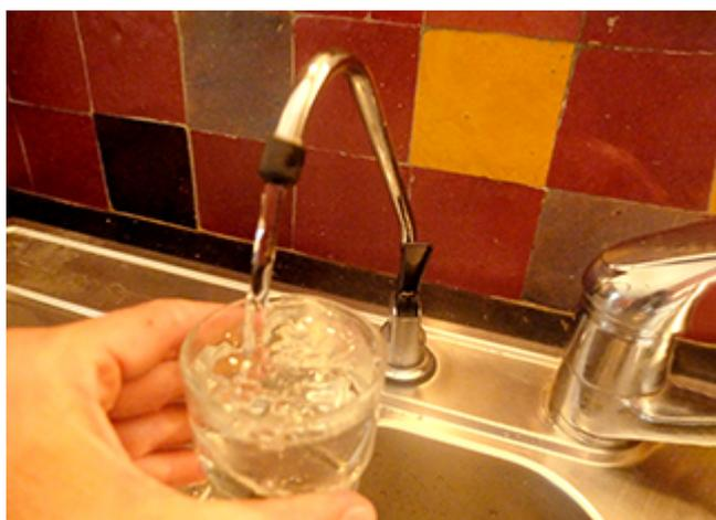
Ici, un robinet d'eau de pluie (potabilisée) est installé à côté du robinet classique (eau chaude et froide de ville) dans la cuisine.
