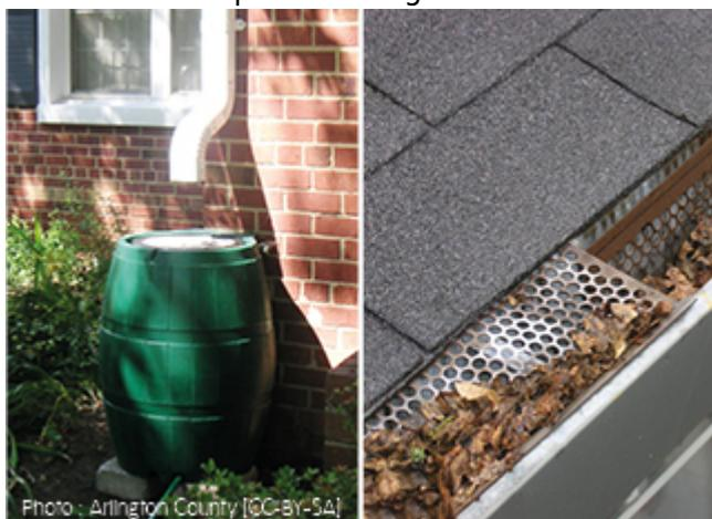
Pour éviter que les feuilles tombent dans la réserve d'eau de pluie, on peut placer des grilles. À gauche, une grille sur le tonneau de récupération, à droite un grillage sur les gouttières
