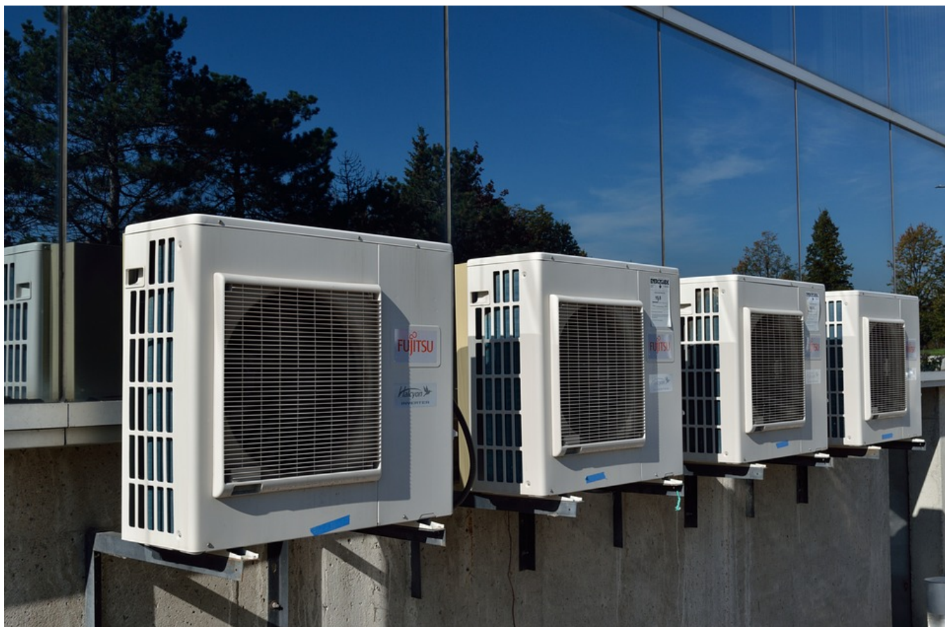
Exemple de climatiseur split : la partie à l'intérieur souffle de l'air froid, la partie à l'extérieur évacue l'air chaud.
