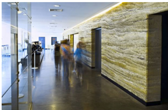
Mur en pisé au Musée Source O Rama à Chaudfontaine, Belgique.
