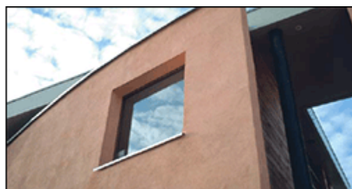
Enduit à caractère isolant Source : www.bcb-tradical.fr
