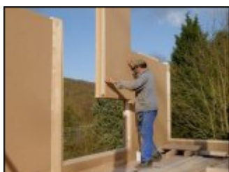
Système constructif « Ecomur »
