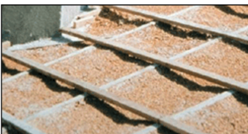
Mortier léger en isolation de toiture Source : www.bcb-tradical.fr
