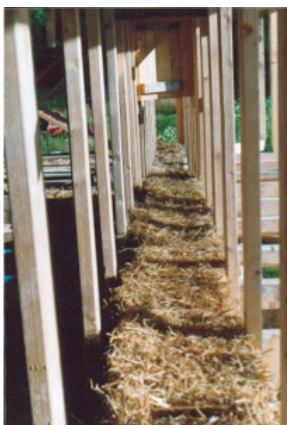
Source : www.greb.ca (Technique dite du « GREB » par pose des ballots de paille dans une ossature double)
