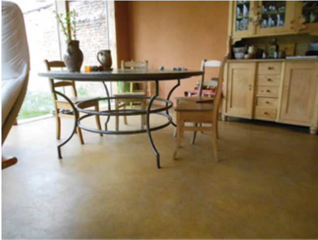
Dalle en terre battue Etienne Guillaume, Elémenterre
