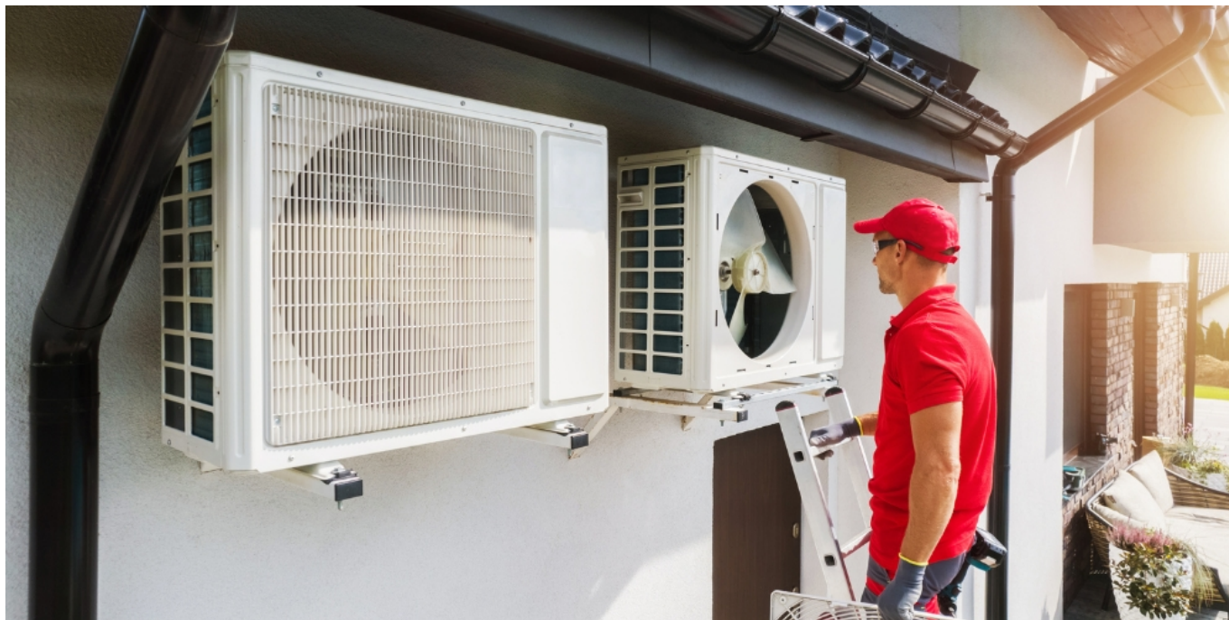
Installation d'une pompe à chaleur qui puise les calories dans l'air.
